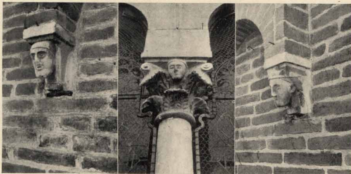
FIG. 4 - TESTE-MENSOLE SUL TIMPANO DELLA FACCIATA DELLA BASILICA DEL SANTO A PADOVA. (FOT. ING. F. ERHARD).
